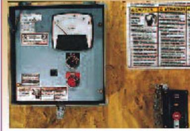
作業者の安全及び利便性向上のため、電流計付コントロールパネル及びリモート式押しボタンステーションが必須装置となります
